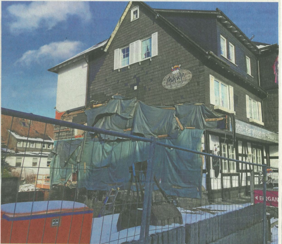
Bereits vor drei Wochen haben die Bauarbeiten für die Erweiterung des „Muh“ve in“ und baldigen „Lodge Hotels“ am Waltenberg in Winterberg begonnen.
